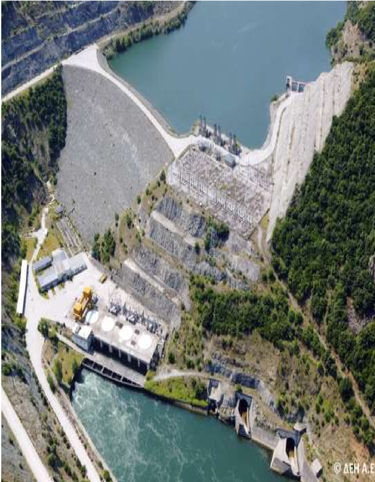
ΔΕΗ: Υδροηλεκτρικός Σταθμός Σφηκιά Βέροια
