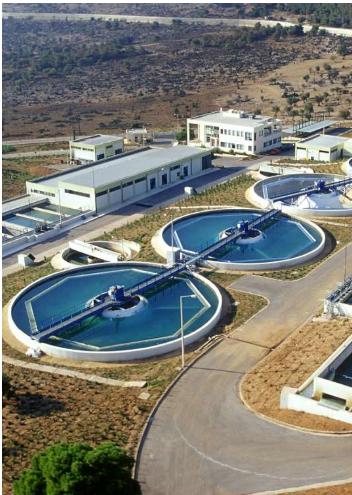
ΕΥΔΑΠ: Κέντρο Επεξεργασίας Υδάτων στον Ασπρόπυργο
