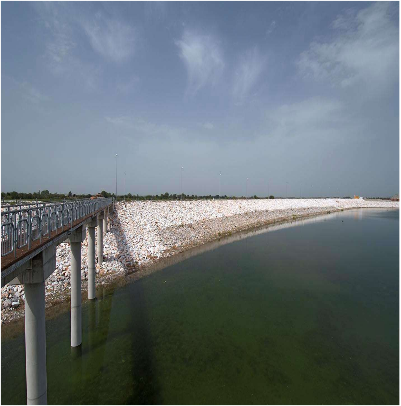
ΕΥΑΘ: Φράγμα Αλιάκμονα
