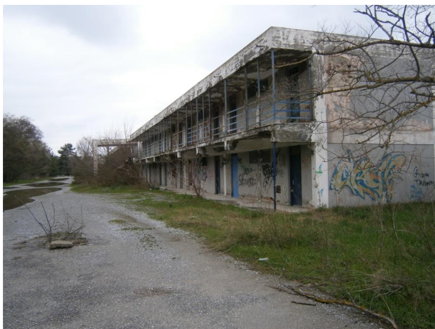
13. Κτιριακό κέλυφος ξενοδοχειακού συγκροτήματος
