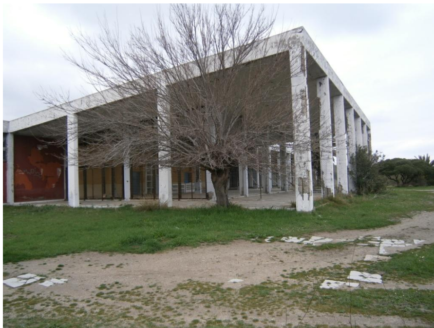
12. Κτιριακό κέλυφος ξενοδοχειακού συγκροτήματος
