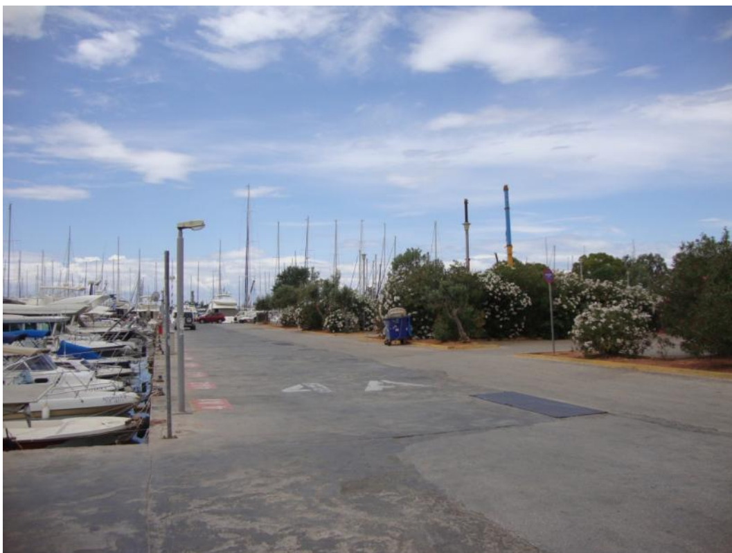
Φωτ. 22: Κρηπίδωμα 4Α. Χώρος στάθμευσης.
