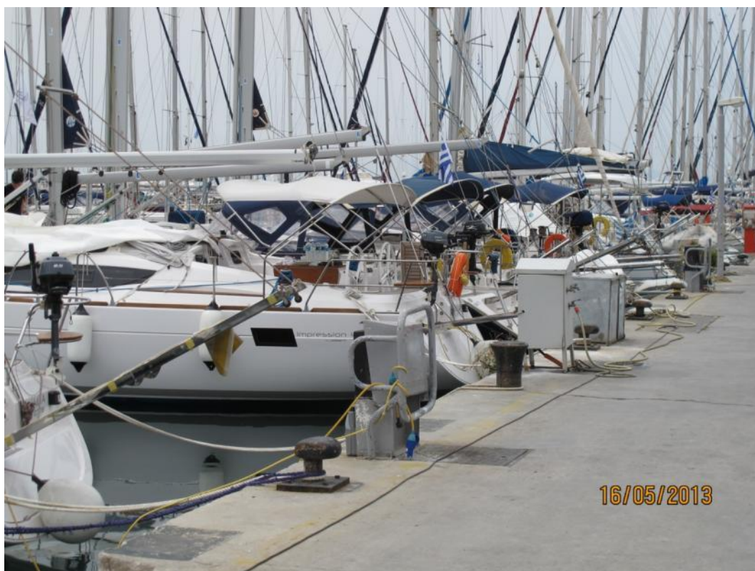
Φωτ. 7: Κρηπίδωμα πρόσδεσης σκαφών προβλήτα 3. Διακρίνονται οι πετपालιωμένες Η/Μ υποδομές.
