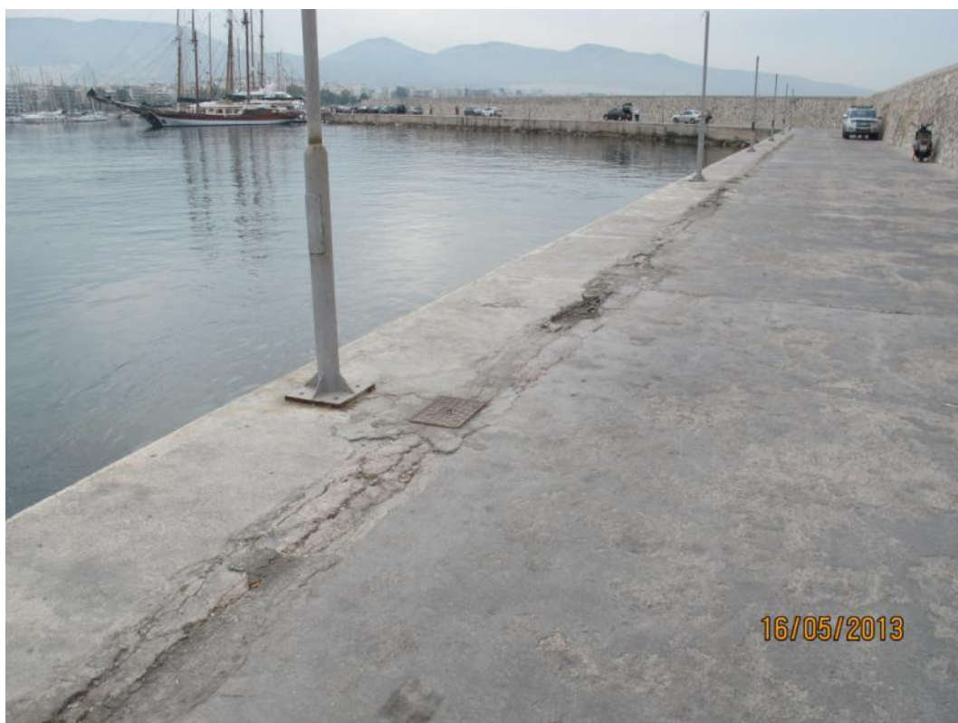
Φωτ. 5: Εσωτερική πλευρά δυτικού τμήματος προσήνεμου μώλου (προβλήτας Ε' – πλησίον εισόδου λιμενολεκάνης).
