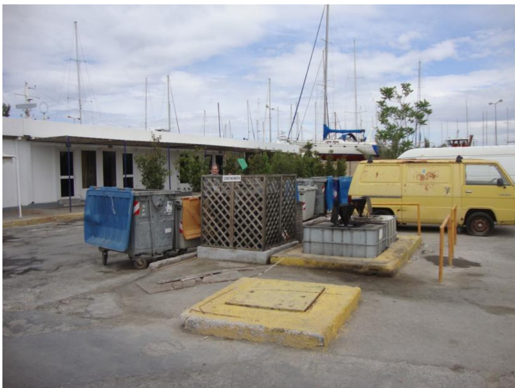
Φωτ. 32: Υποτυπώδεις υποδομές παραλαβής καταλοίπων
