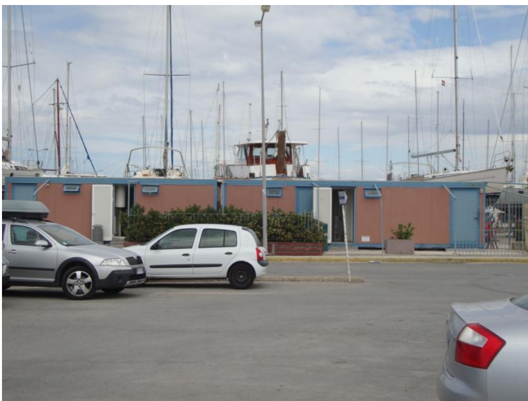
Φωτ. 18: Χώροι υγιεινής (πρόχειρες κατασκευές) πλησίον του χώρου χερσαίας απόθεσης.
