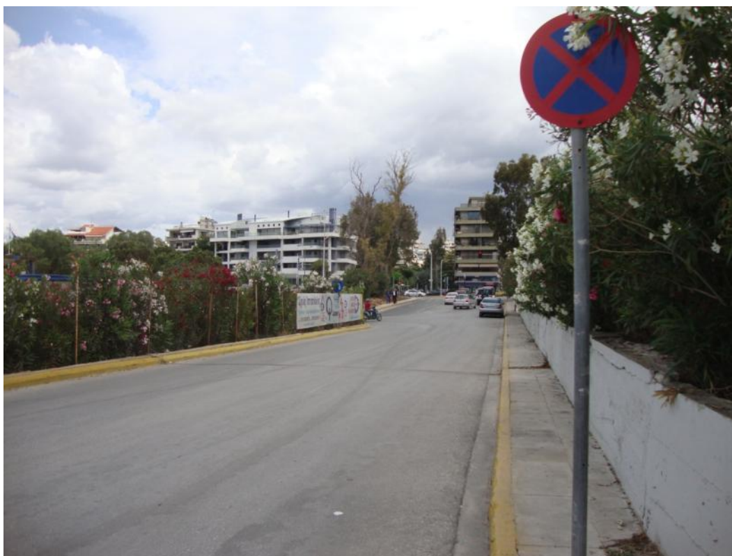
Φωτ. 30: Εσωτερικό οδικό δίκτυο
