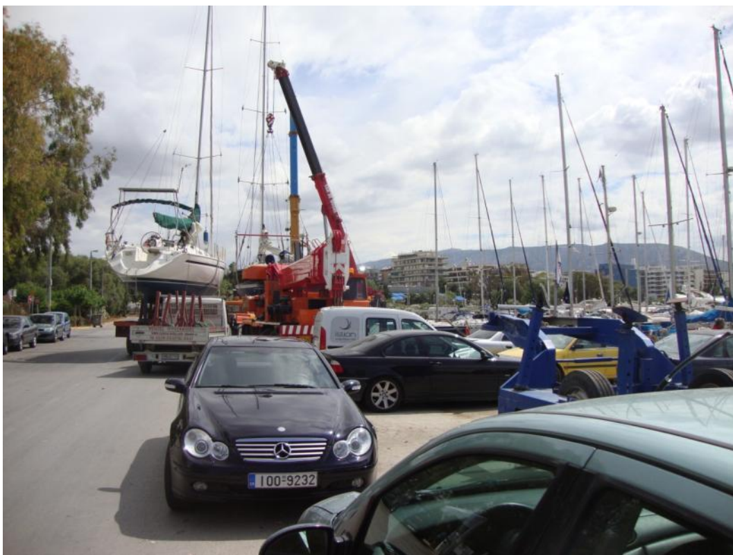
Φωτ. 15: Ανεξέλεγκτη στάθμευση οχημάτων, γερανών και trailer στο χερσαίο χώρο προ του κρηπιδώματος 3Κ.
