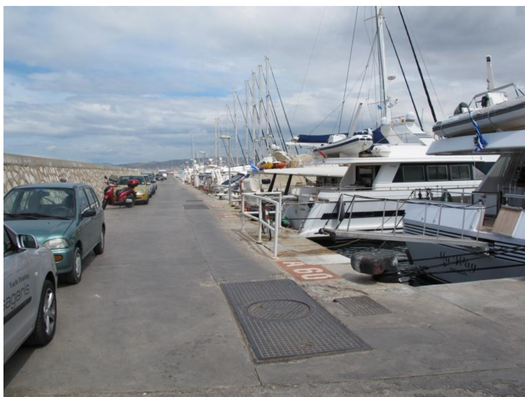
Φωτ. 6: Εσωτερική πλευρά υπήνεμου μώλου (προβλήτας Α').
