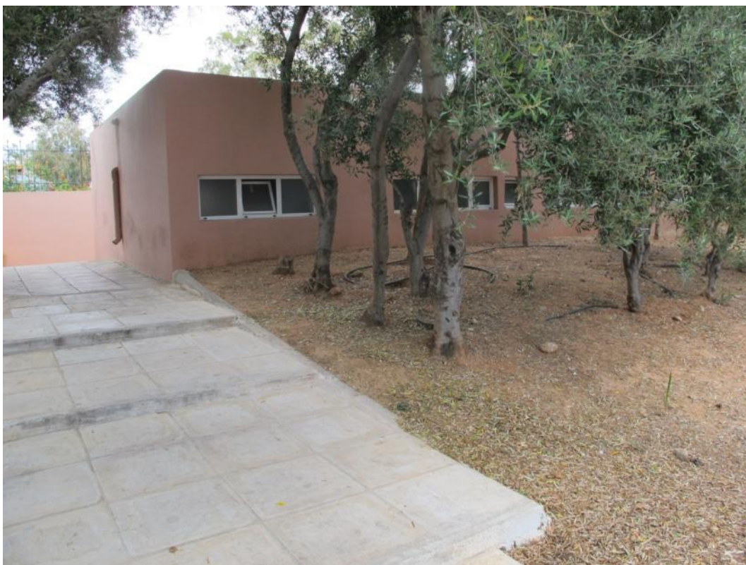
Φωτ. 21: Χώροι υγιεινής.
