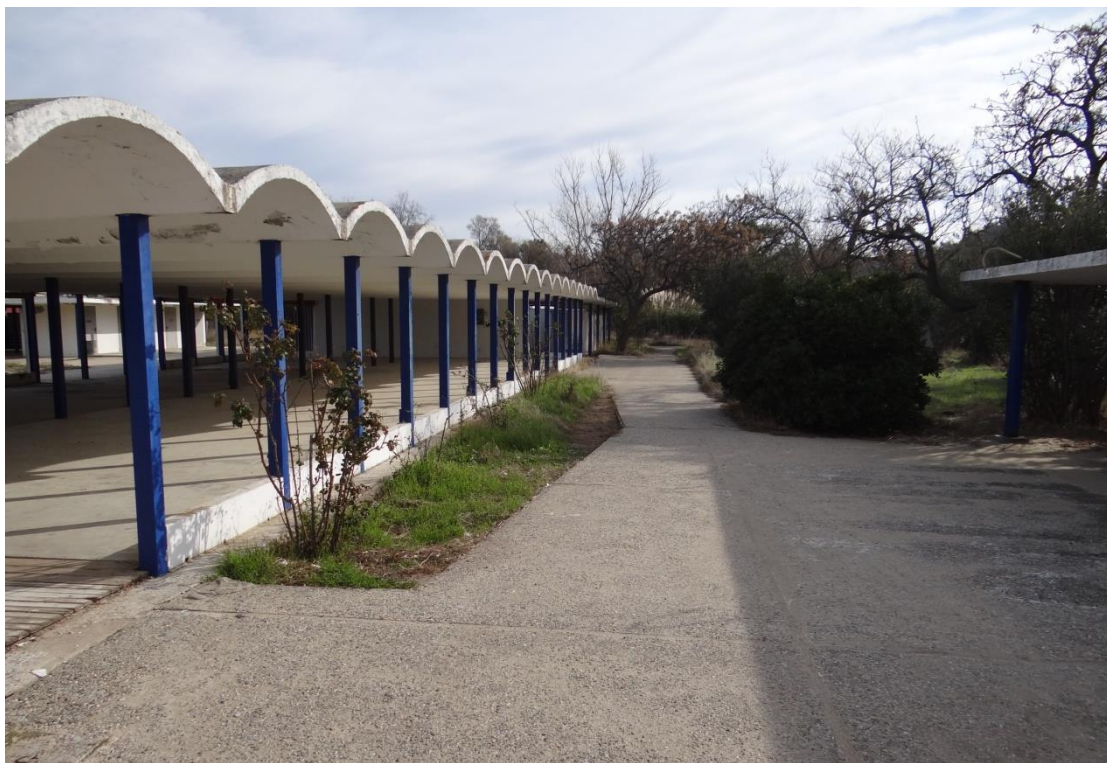
Φωτογραφία 17: Άποψη εγκαταλελειμμένων κτιριακών εγκαταστάσεων του παλαιού κάμπινγκ.
