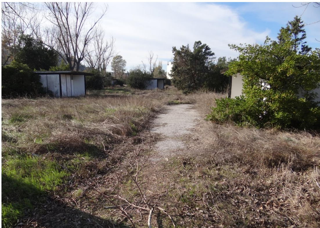
Φωτογραφία 26: Χαρακτηριστική εικόνα τμήματος της ιδιοκτησίας. Διακρίνονται εγκαταλελειμμένα κτίρια και τμήμα του εσωτερικού οδικού δικτύου του παλαιού κάμπινγκ.
