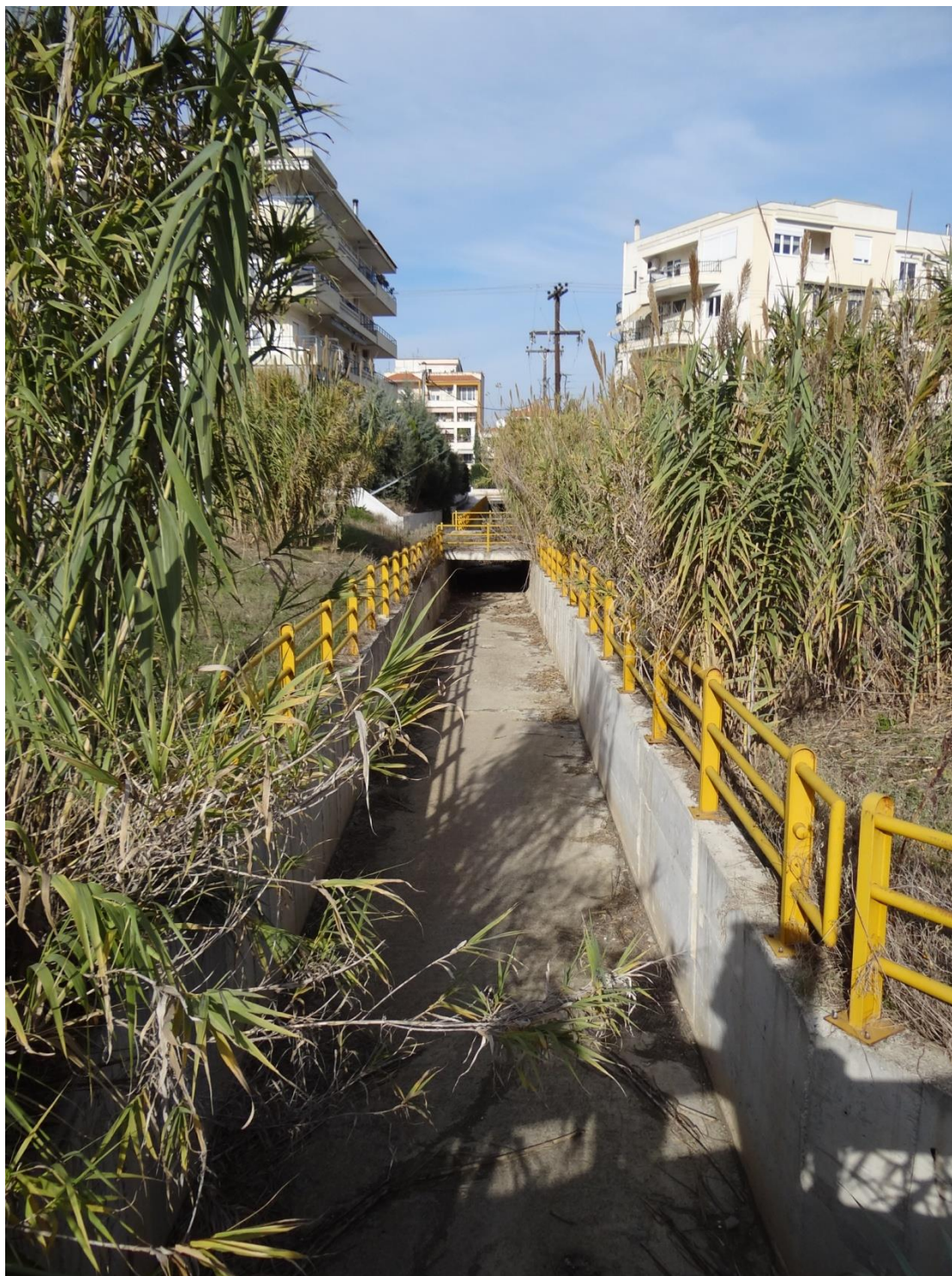
Φωτογραφία 21: Διευθετημένο ρέμα που διέρχεται από περιοχή κατοικίας σε απόσταση περίπου 120 μέτρων ανατολικά της ιδιοκτησίας όπως φαίνεται από την Λεωφόρο Θεσσαλονίκης – Μηχανιώνας. (Κατεύθυνση φωτογραφίας: Β)
