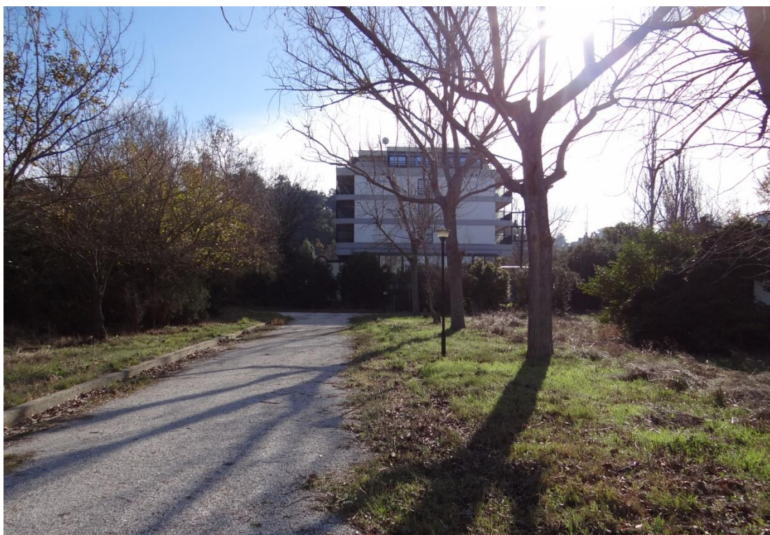
Φωτογραφία 27: Υφιστάμενο Ξενοδοχείο “sun beach hotel” όπως φαίνεται από το παλαιό κάμπινγκ. (Κατεύθυνση φωτογραφίας: Ν)
