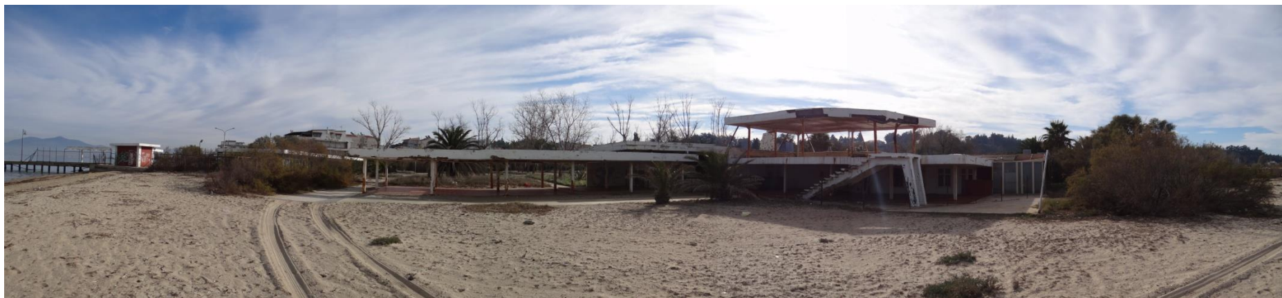
Φωτογραφία 4: Πανοραμική άποψη κτιριακών εγκαταστάσεων του παλαιού κάμπινγκ στην παραλιακή ζώνη της ιδιοκτησίας. (Κατεύθυνση φωτογραφίας: ΝΑ, Ν)
