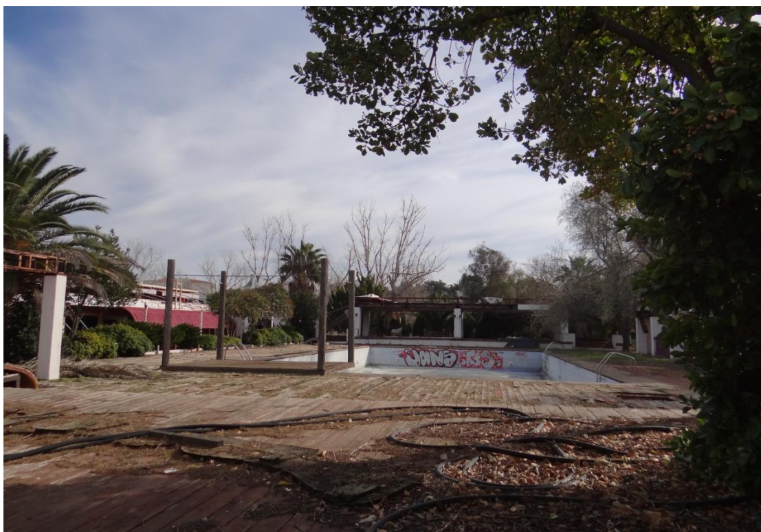
Φωτογραφία 18: Άποψη εγκαταλελειμμένων κτιριακών εγκαταστάσεων του παλαιού κάμπινγκ.
