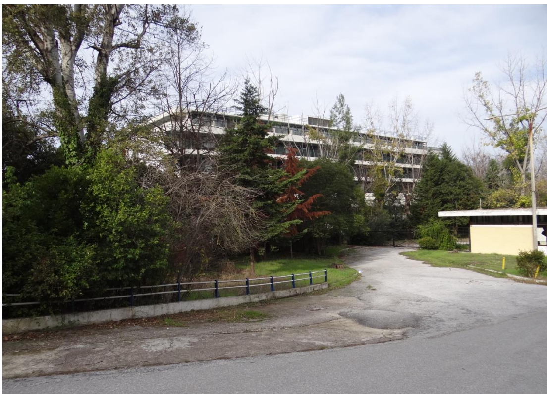
Φωτογραφία 12: Υφιστάμενο Ξενοδοχείο “sun beach hotel” δυτικά της νότιας εισόδου του παλαιού κάμπινγκ.
