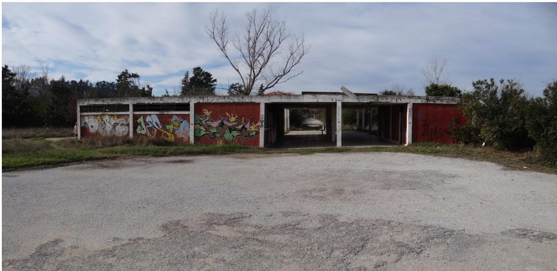
Φωτογραφία 8: Άποψη κτιριακών εγκαταστάσεων του παλαιού κάμπινγκ.
