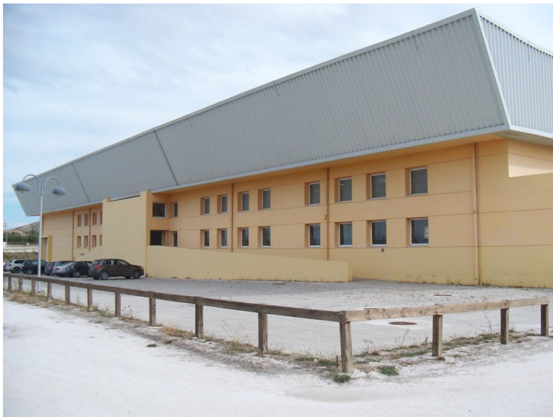
Φωτογραφία 5: Εξωτερική όψη της κλειστής αρένας του Ιππικού Κέντρου
