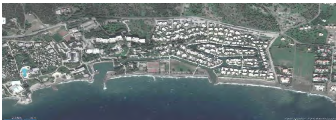
Εικόνα 6-11: Τα συγκροτήματα Porto Hydra και Hydra Beach (Πηγή: bing maps)
