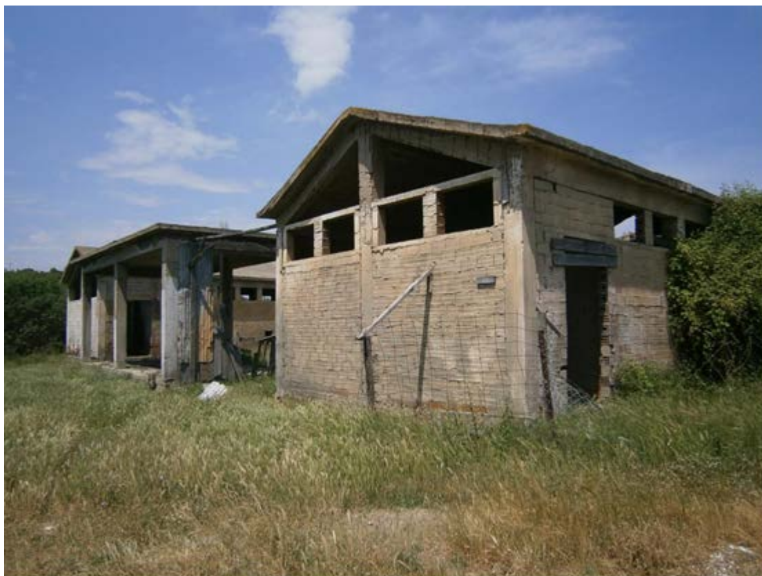
17. Εγκαταλειμμένο κτίριο αποδυτηρίων και βοηθητικών χώρων του camping
