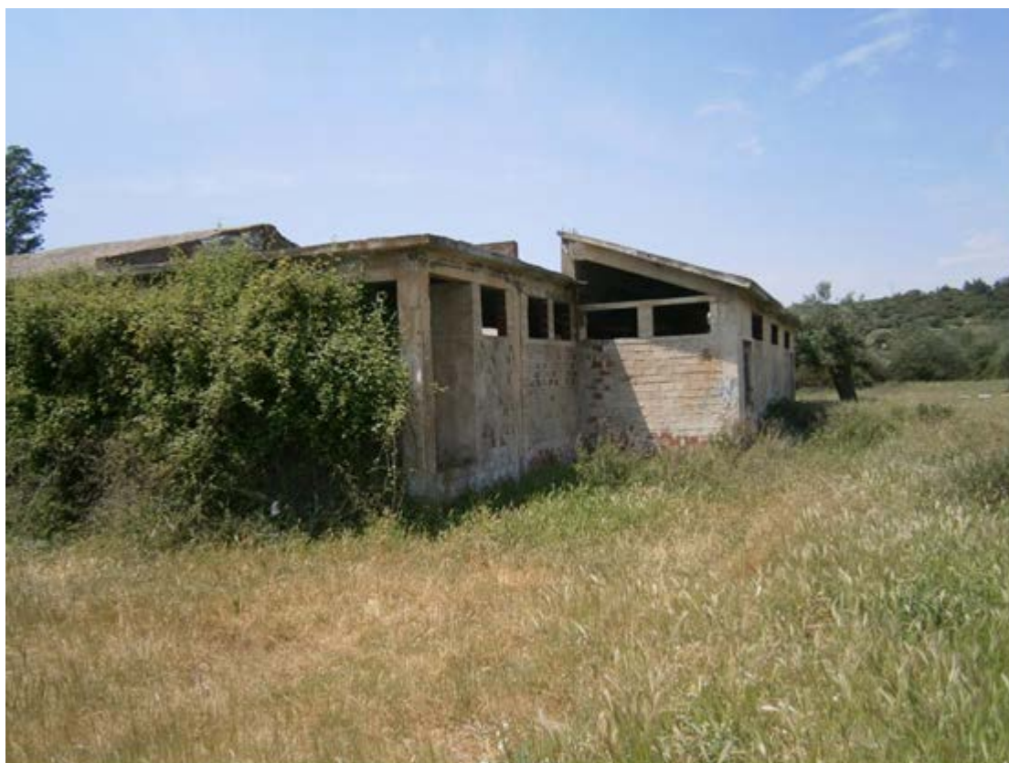
16. Εγκαταλειμμένο κτίριο αποδυτηρίων και βοηθητικών χώρων του camping
