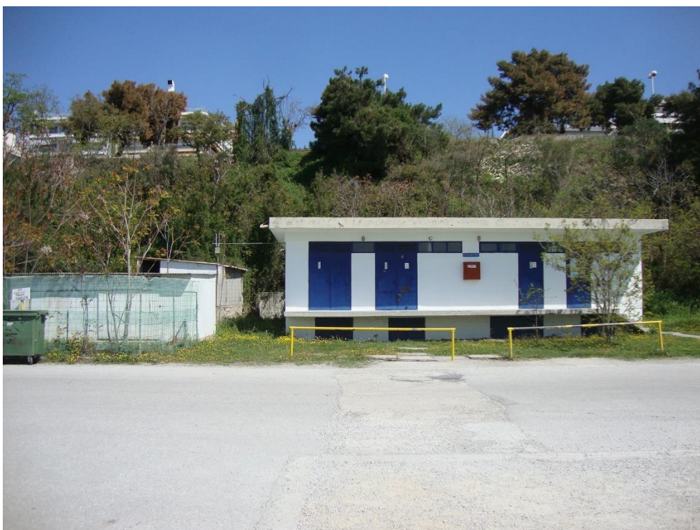
Φωτ. 8 Κτίριο υποσταθμού και χώροι αποθήκευσης για πετρελαιοειδή
