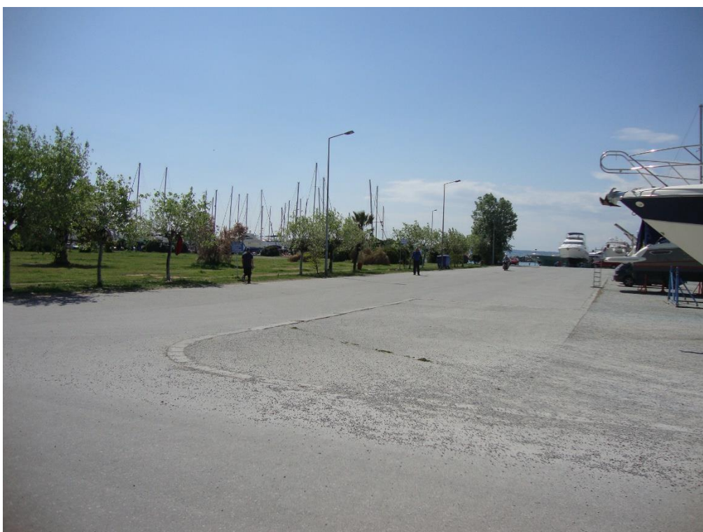
Φωτ. 9 Χερσαία ζώνη μαρίνας – υφιστάμενος χώρος πρασίνου
