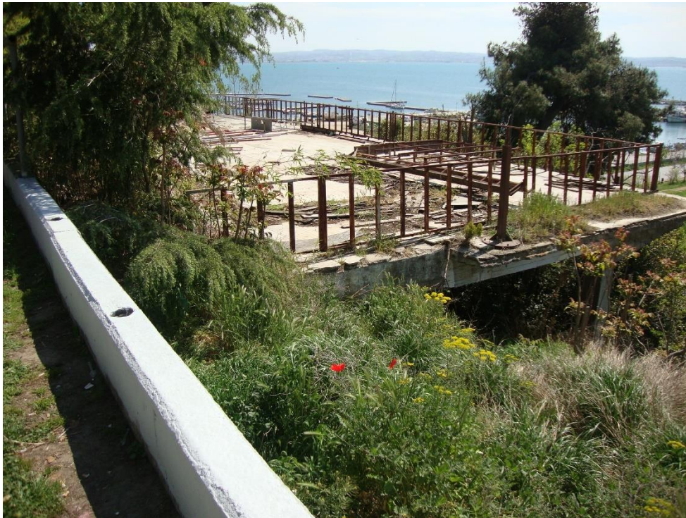
Φωτ. 12 Υφιστάμενη βεράντα επί υποστυλωμάτων
