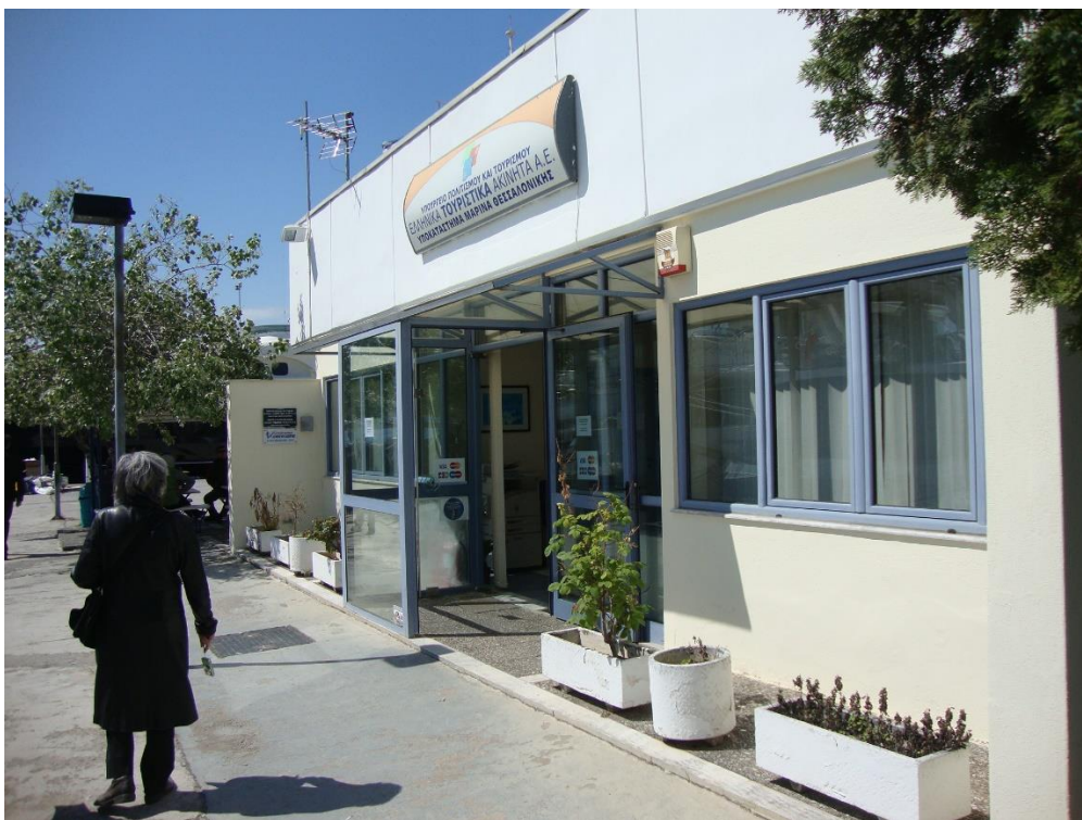
Φωτ. 7 Είσοδος κτιρίου διοίκησης μαρίνας
