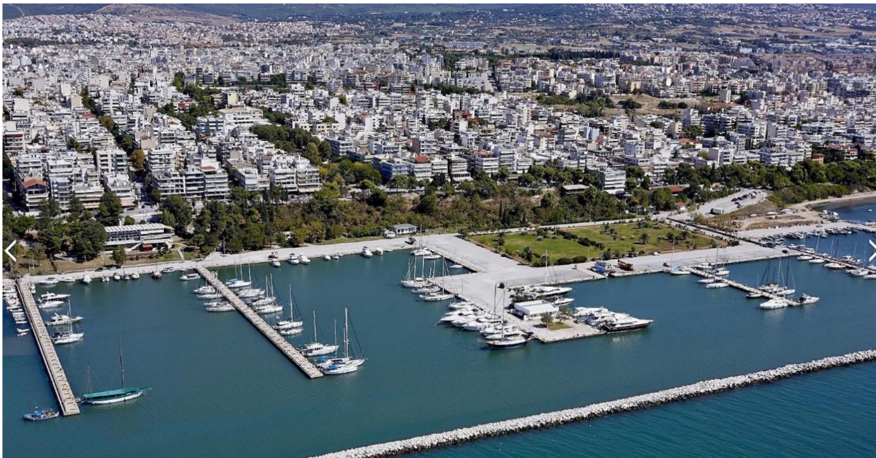
Φωτ. 1 Μαρίνα Καλαμαριάς - λήψη από ψηλά (Πηγή: www.tripinview.com )
