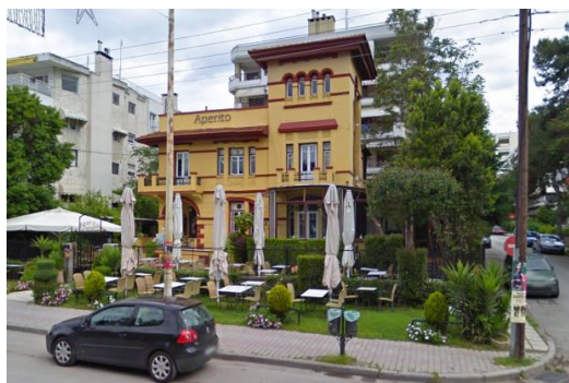
1. Αστικό κτίριο στην οδό Πλαστήρα 69
