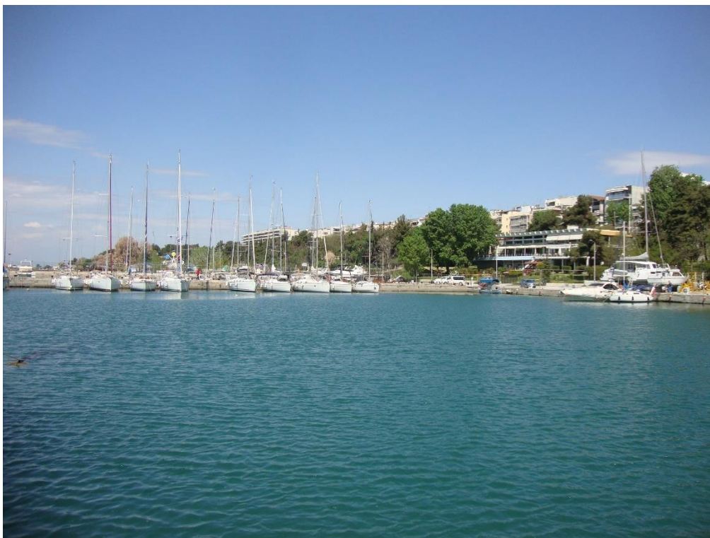
Φωτ. 6 Άποψη βορειοδυτικού τμήματος μαρίνας, κεντρικό κτίριο
