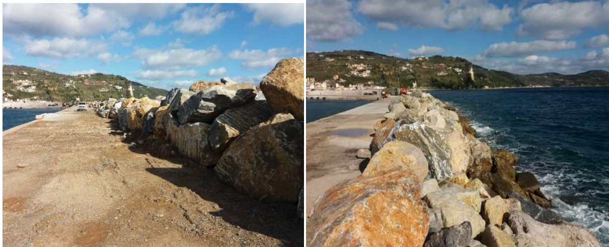
Εικόνα 4-34: Τμήμα μη επιστρωμένου τμήματος - Κατάσταση θωράκισης
