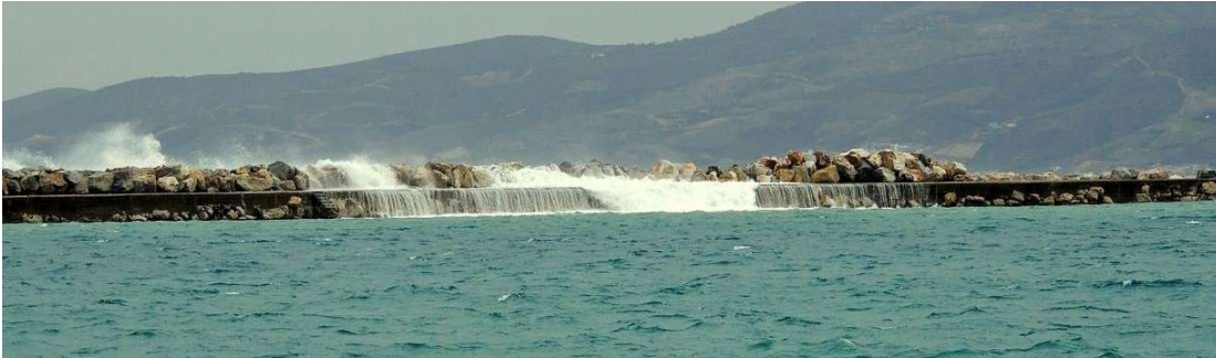
Εικόνα 4-32: Υπερπήδηση κυματισμού από τον υφιστάμενο προσήνεμο μώλο 3-2013 – τμήμα με εσωτερική κρηπίδωση (Πηγή: koumiotis.blogspot.gr)
