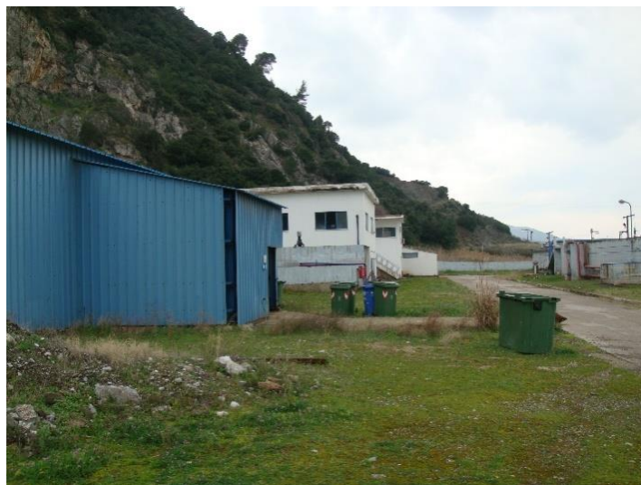
Εικόνα 6.3-4: Μονάδα βιολογικού καθαρισμού της πόλης
